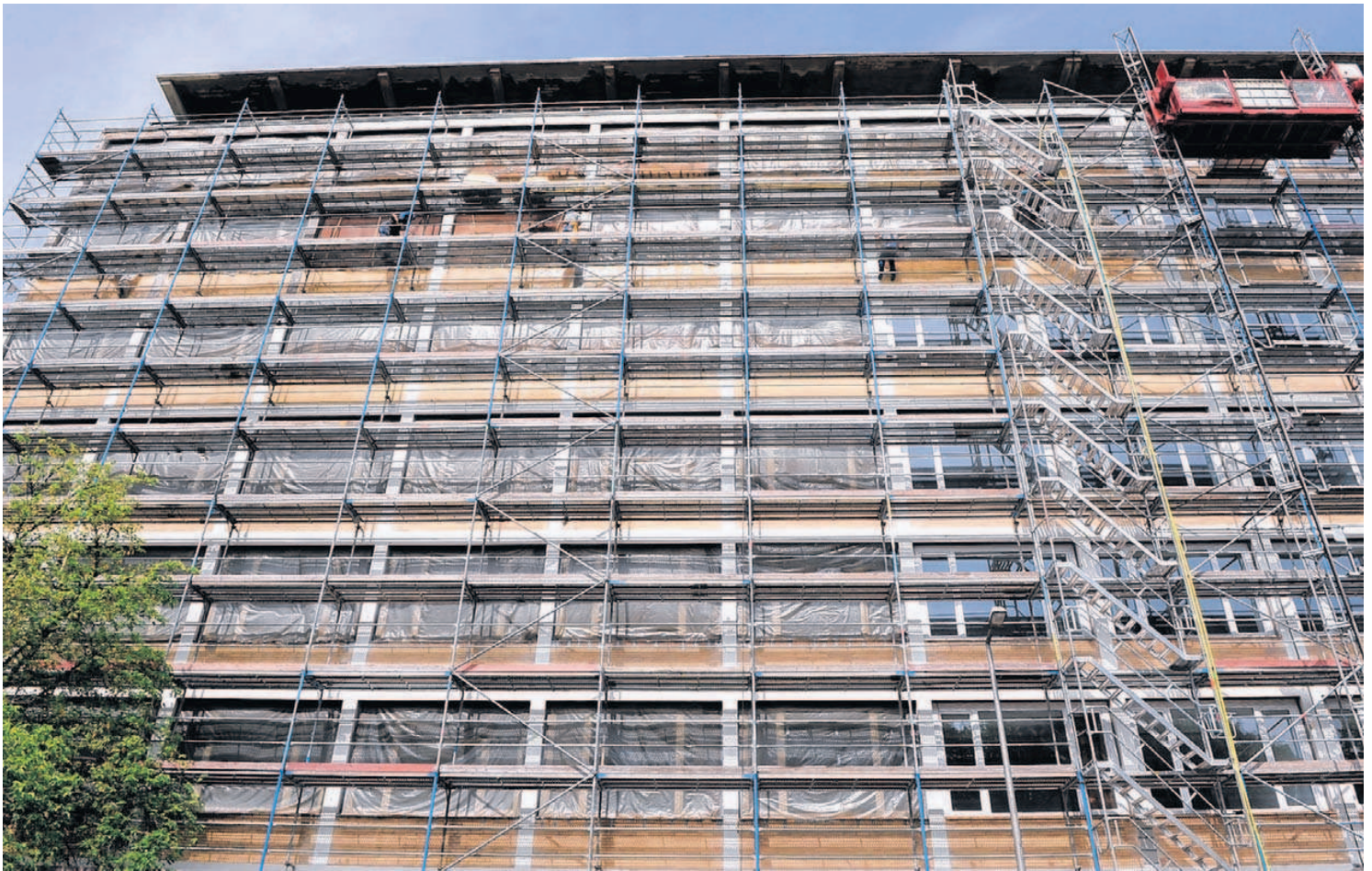
Komplett eingerüstet: Die Heinrich-Lanz-Schule erhält für 880 000 Euro neue Fenster inklusive Brüstungen.
